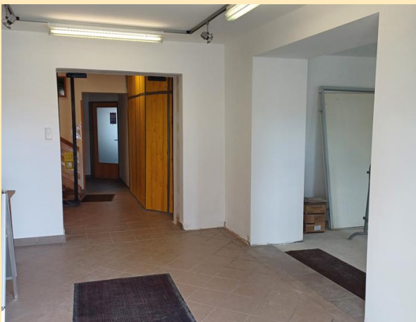
Die Umbauarbeiten im Foyer des Amtshauses schreiten voran.
